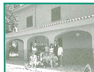
COMUNIDAD TERAPÉUTICA DEL P.H. PLASENCIA (EXTREMADURA)
