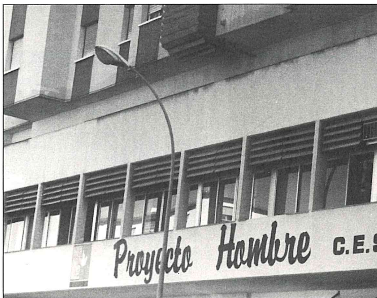
Fachada del Centro de Acogida del P.H. de Málaga
